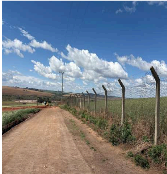
Figura 57: Cercamento da área do aterro sanitário de Ponta Grossa/PR.
