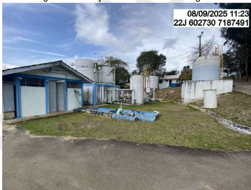
Figura 19: Vista geral da Estação de Tratamento de Água de Palmeira/PR.
