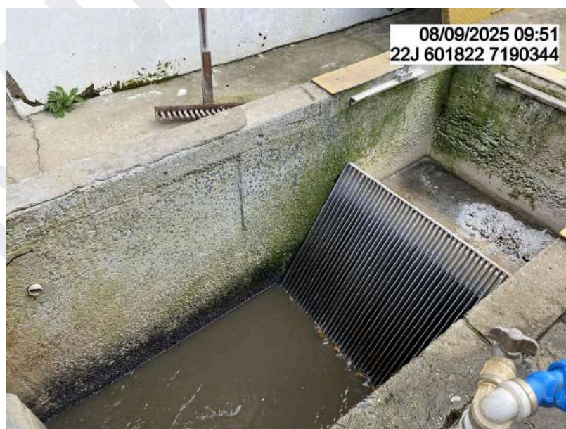
Figura 39: Gradeamento na chegada do esgoto bruto à Estação de Tratamento de Esgoto.
