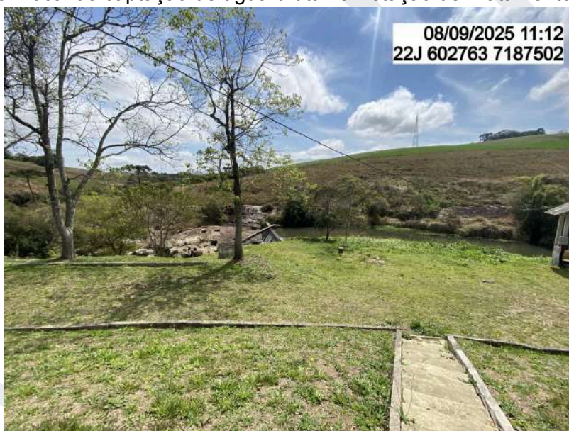
Figura 23: Local de captação de água bruta na Estação de Tratamento de Água.
