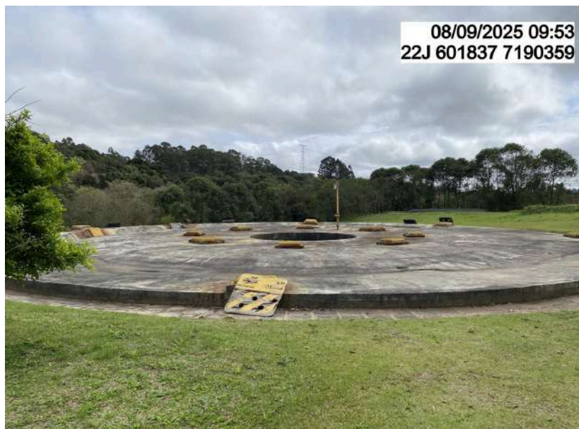
Figura 36: Tanque digestor de lodo da Estação de Tratamento de Esgoto.
