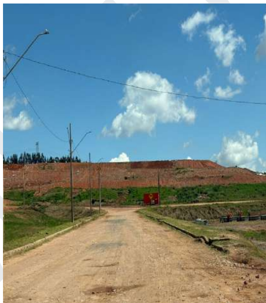
Figura 56: Área já utilizada com células encerradas do aterro sanitário de Ponta Grossa/PR.
