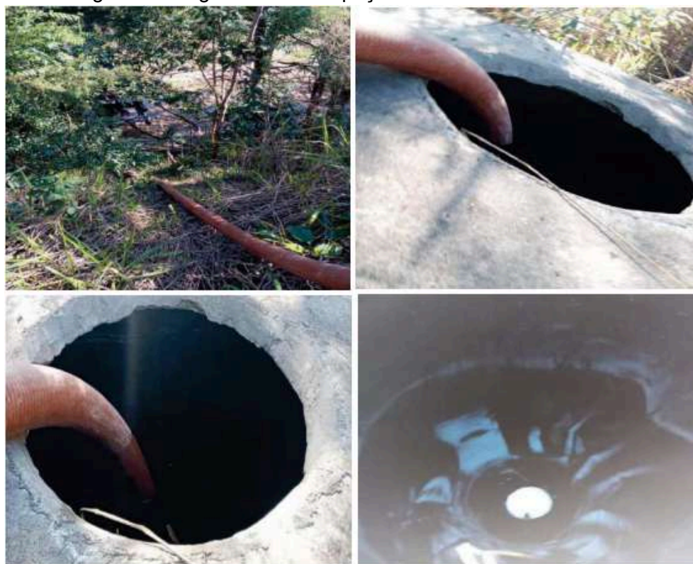
Figura 69: Esgotamento dos poços de acúmulo de chorume.
