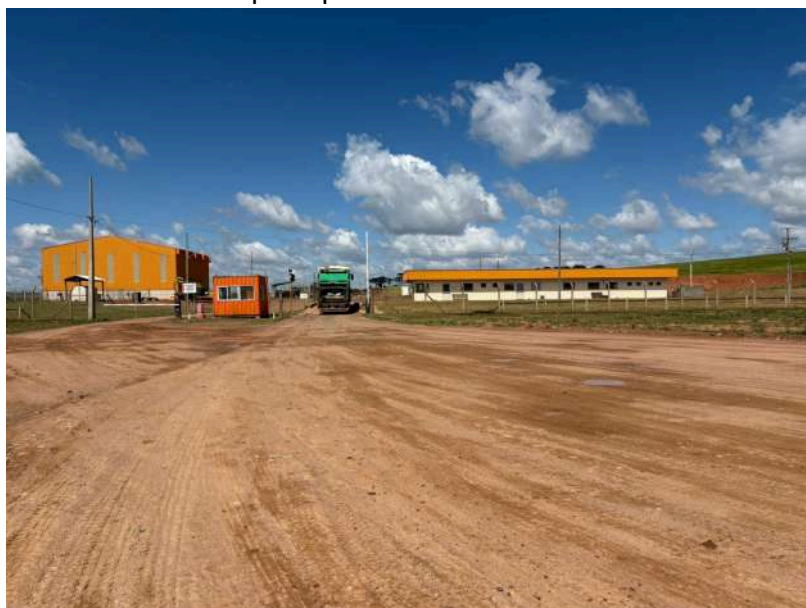
Figura 53: Acesso e entrada principal do aterro sanitário de Ponta Grossa/PR.
